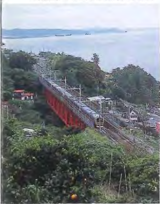
▼東海道本線根府川駅の南、白糸川に架かる白糸川橋梁(大正14年開通)は土木遺産認定の名橋
