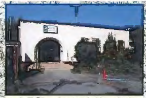
▲倉見駅。大正15年築、当時画期的な鉄筋コンクリート耐震造
