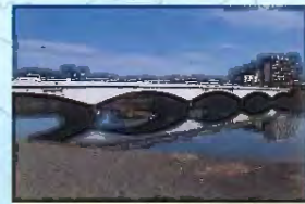
▲花水川橋。昭和9年竣工、国道134号が平塚～大磯間を渡ります
