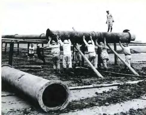
埋め立ての光景。砂を運ぶ土管を人力で組み上げる。当時は浮島町や千鳥町の造成が進められていた（昭和37年）。
