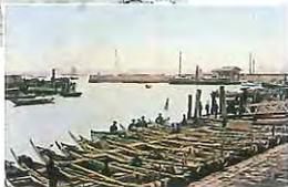
横浜開港前年の安政五年（一八五八）、横浜村に設定された運上（うんじょう）所（当時の税関）の北側海面に二本の突堤が設けられ、最初の波止場が完成しました。のちにできるフランス波止場に対してイギリス波止場とも言われます。その東側の突堤が第一突堤（狭義のイギリス波止場）、西側が第二突堤（旧国産波止場、税関波止場とも）で第一突堤が現在の大桟橋の根元付近とのこと。また、当時の出版物から、開港直後の波止場築造時には常夜灯（灯明台）が設置されていたことが確認されています。
